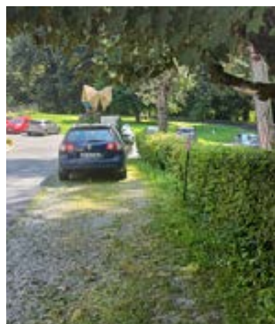
Saint-Gervais-les-Bains - Stationnement sur concassé enherbé
