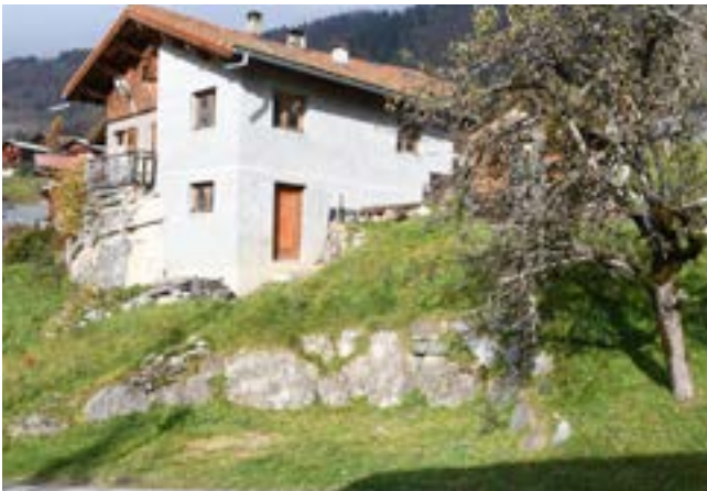
Servoz - hameau du Mont - Encoche pour stationnement
