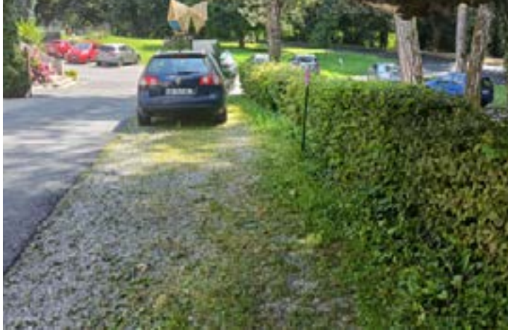
Saint-Gervais-les-Bains - Revêtement de stationnement simple et rustique
