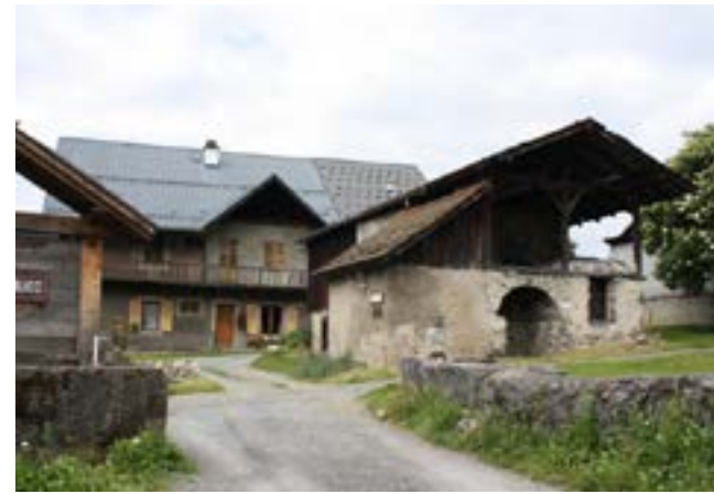
Accotement des rues enherbé et arboré / le Sisera - Vallorcine
