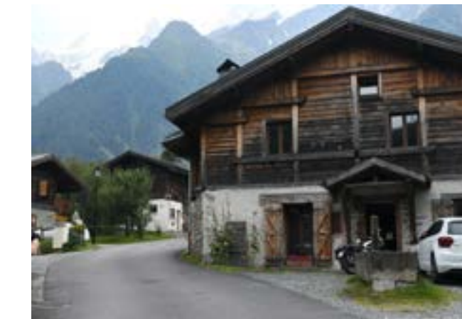
Cour de desserte et stationnement - hameau du Mont / Servoz
