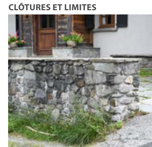
Muret en pierre / route de la Griaz - Les Houches
