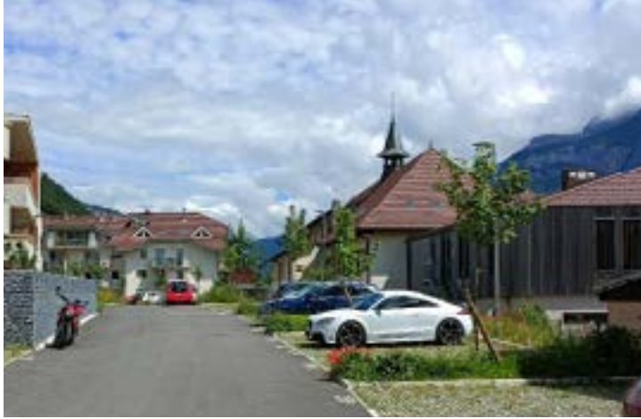
Sallanches - Stationnement perméable et végétalisé
