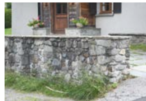
Muret en pierre route de la Griaz - Les Houches
