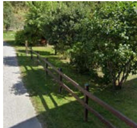
Clôture bois / route de Bionnay - Saint-Gervais
