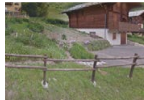
Clôture bois hameau du Mont - Servoz
