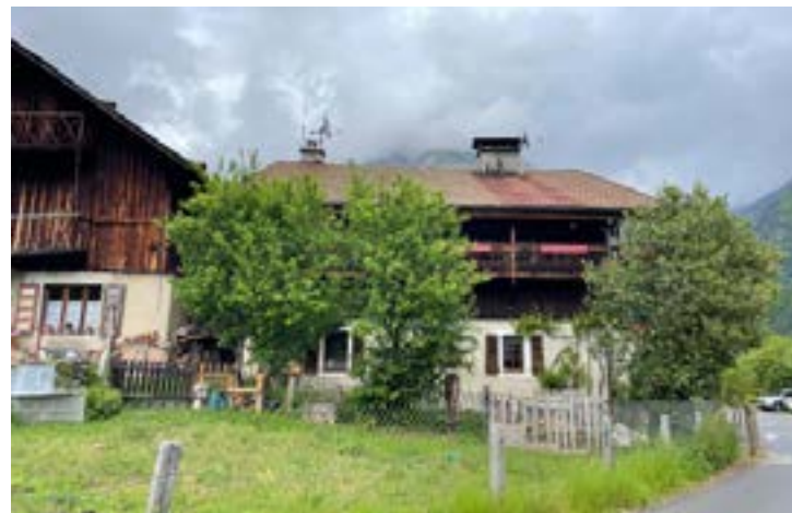
Servoz - Transparences des clôtures et ponctuations arborées en pied de façade
