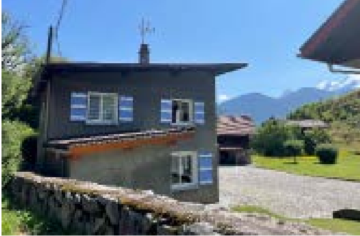
Chedde / Passy - Clôture en muret pierre
