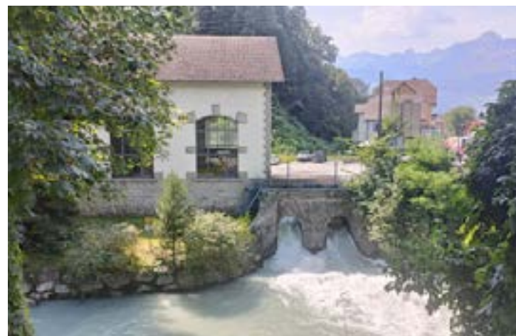
Centrale hydro-électrique du Fayet - Saint-Gervais-les-Bains
