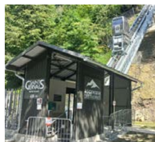
Ascenseur hydraulique - Saint-Gervais-les-Bains
