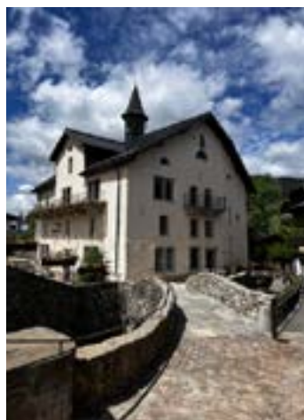
Passerelle piétonne - Megève
