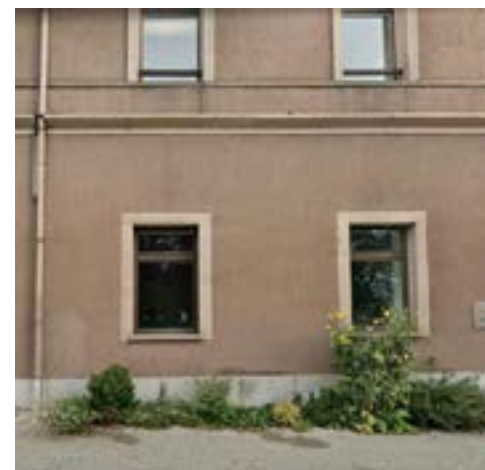
Sallanches - Végétalisation du pied de façade de la mairie
