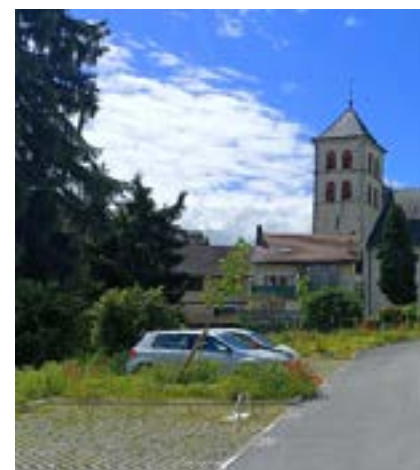
Sallanches - Stationnement perméable en pavés enherbés
