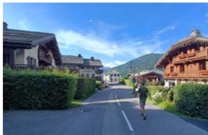
Saint-Gervais-les-Bains / Saint-Nicolas-de-Véroce - Accotements enherbés et traitement végétal des limites qui qualifient la traversée.
