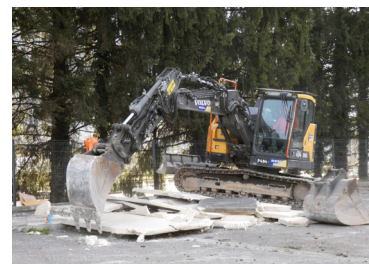
la destruction des anciennes installations
